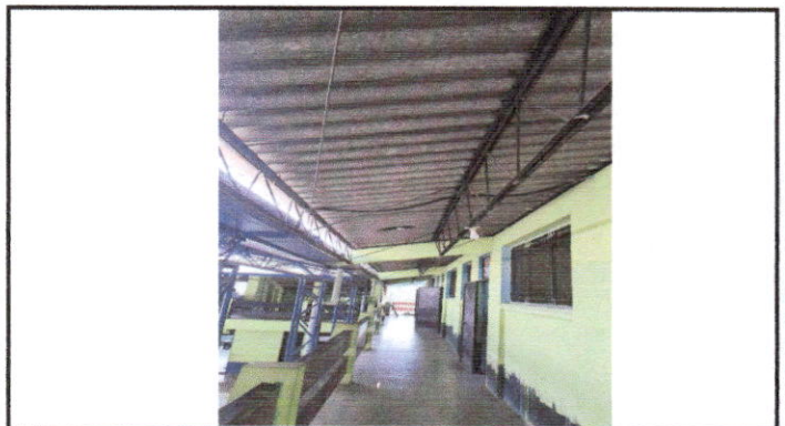
Foto 4: sustitución de duralita por lamina troquelada calibre 26 y mantenimiento de soporte de metal
