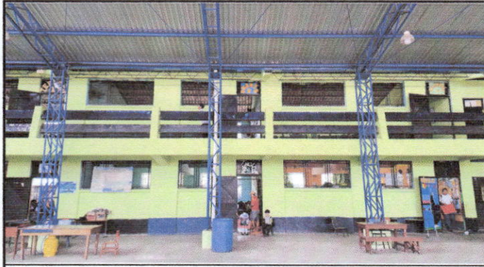
Foto 1: sustitución de duralita por lamina troquelada calibre 26 y mantenimiento de soporte de metal
